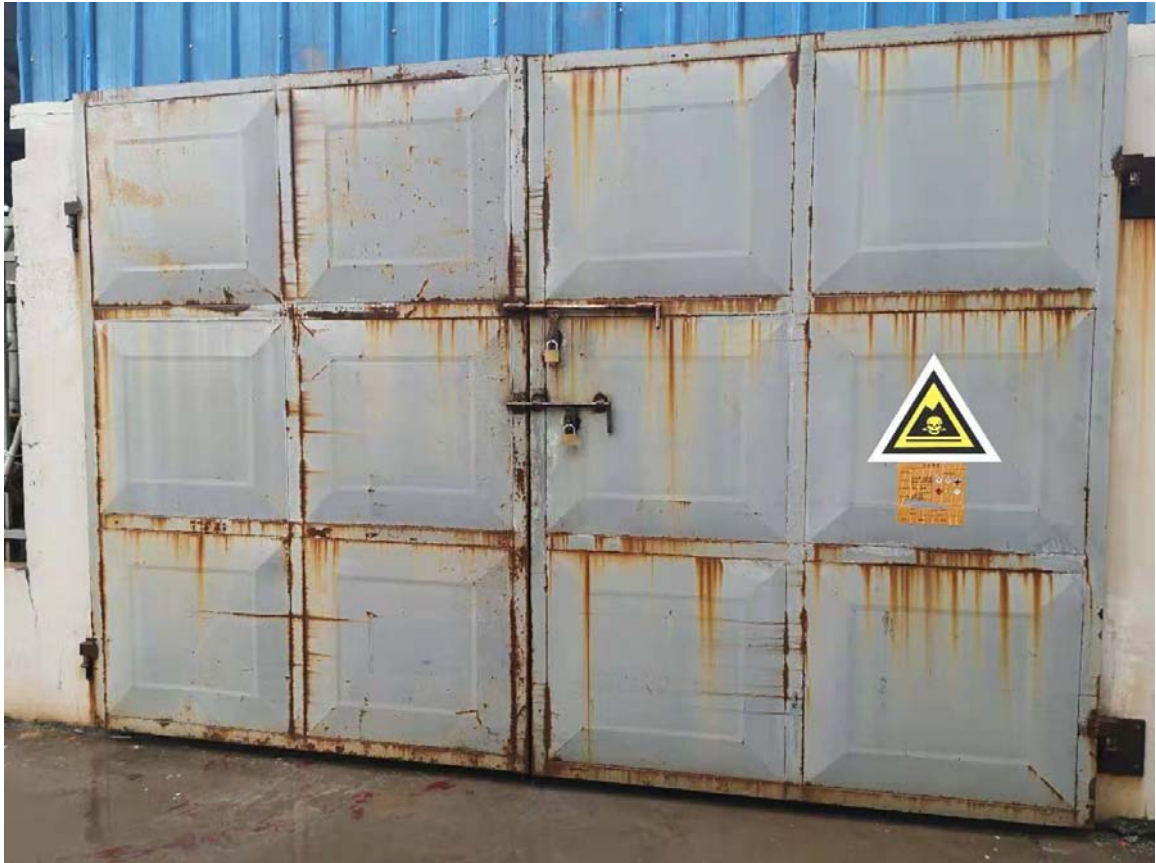
厂区危废仓库
