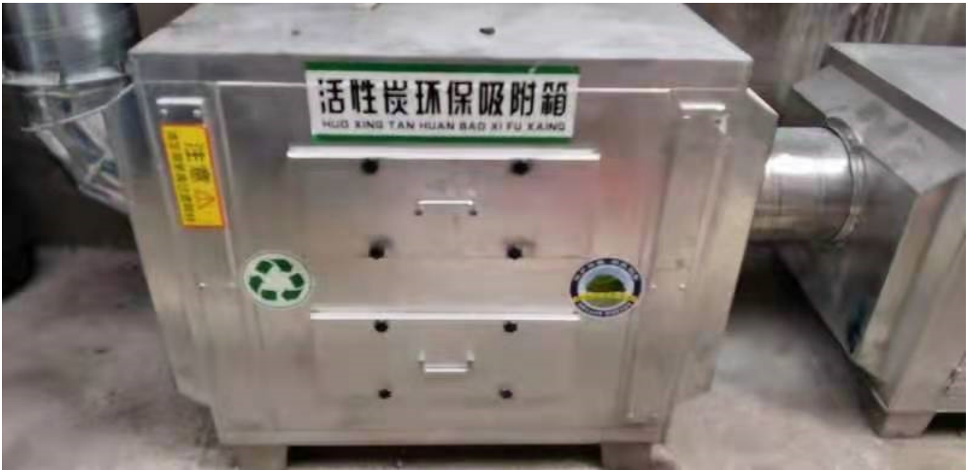
附图2 废气处理设施照片
