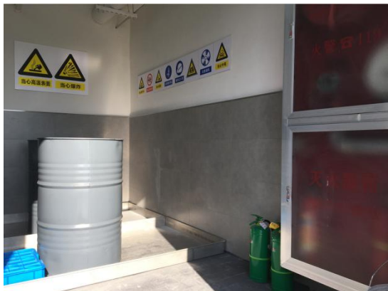
危废暂存间（一楼）
