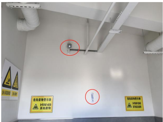
危废暂存间（一楼）
