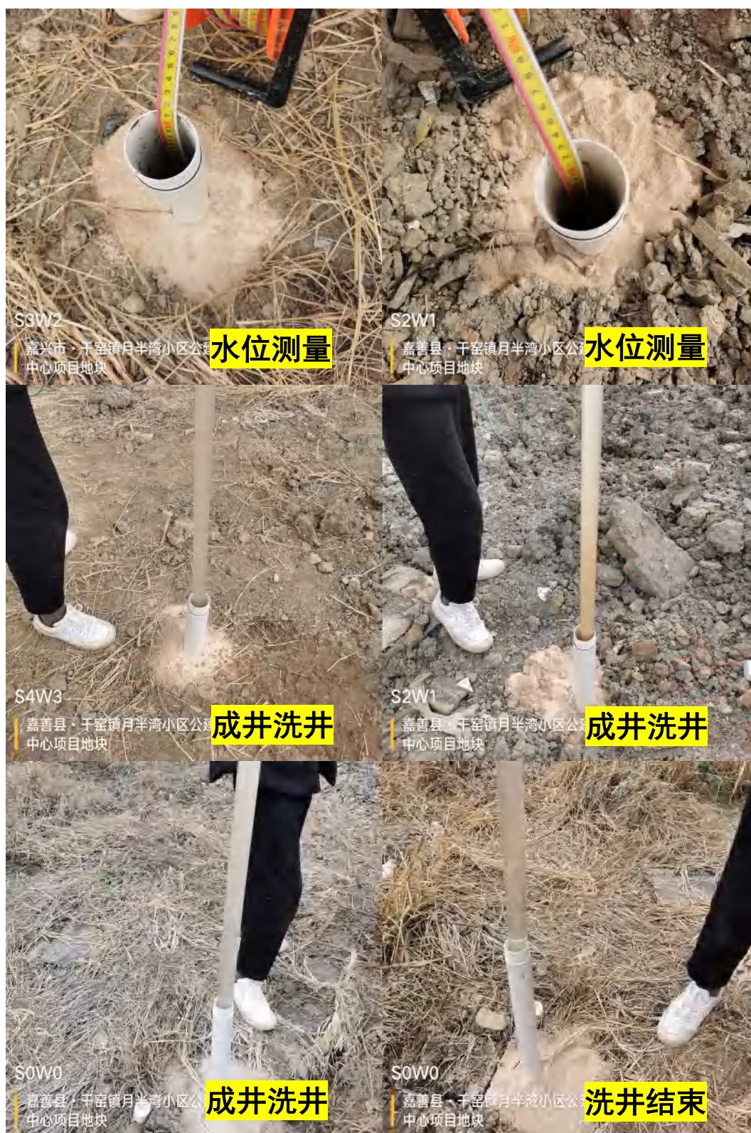
图 8 部分成井洗井照片
