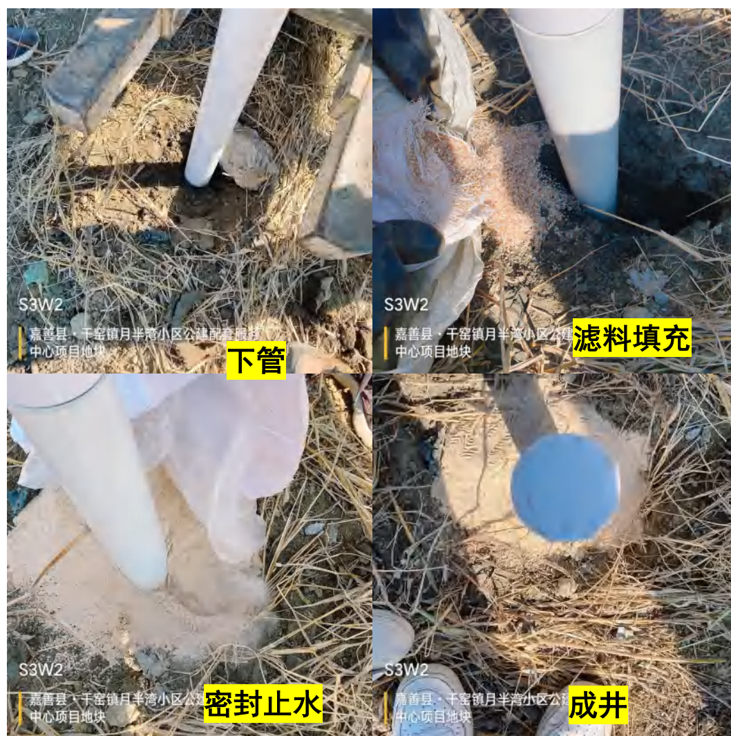
图 7 部分建井照片
