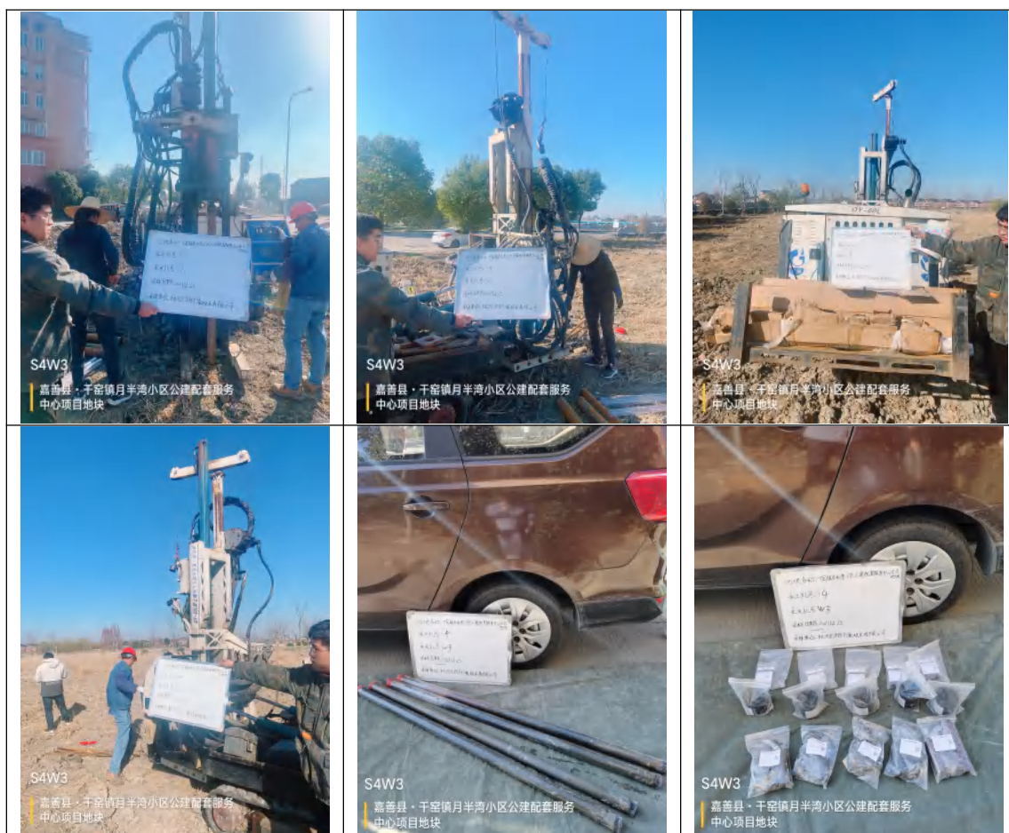
图 5.1.3-2 典型现场钻孔及取样成果照片
