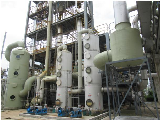
酸喷淋+碱喷淋装置
