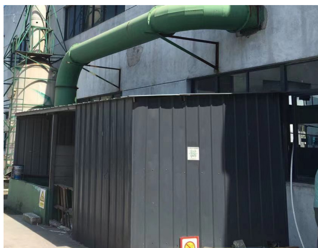
图 4.1.4.3-2 一般固体废物暂存场所
