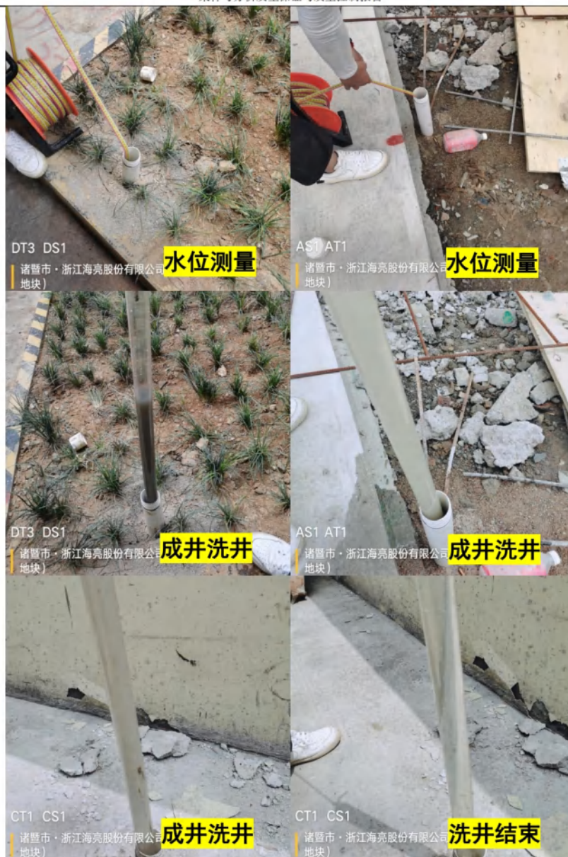
图 3-8 部分成井洗井照片
