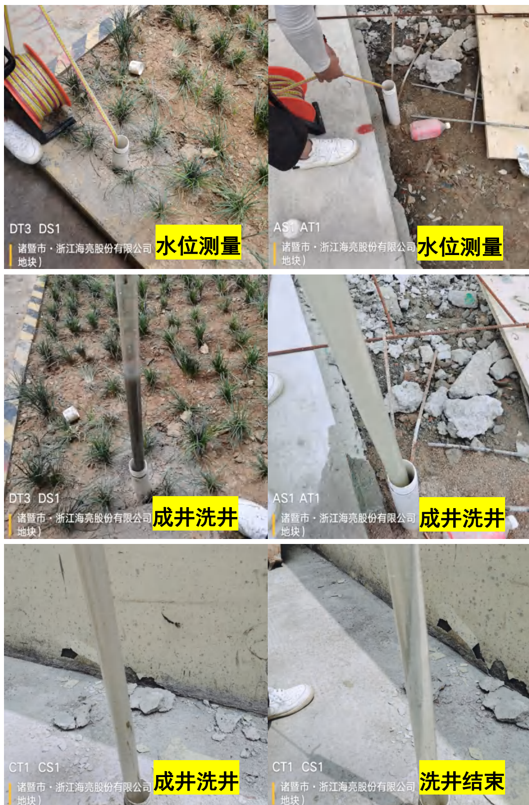
图 7.2-7 部分成井洗井照片
