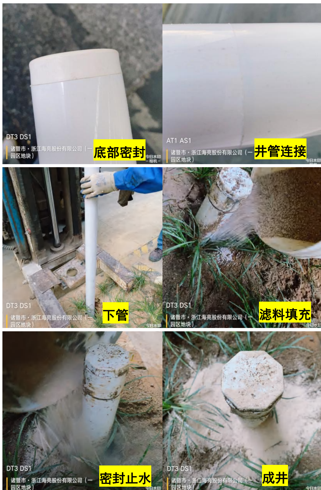
图 7.2-6 部分建井照片
