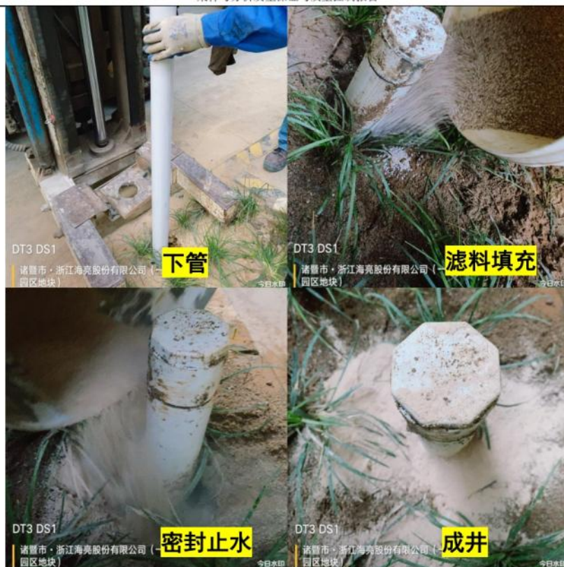
图 3-7 部分建井照片
