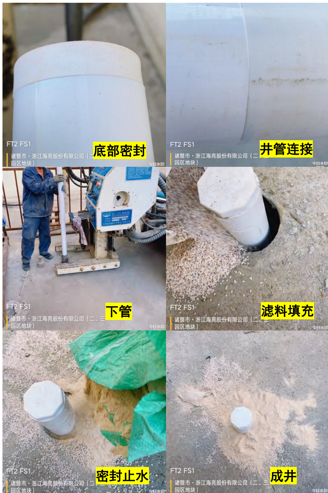
图 7.2-6 部分建井照片
