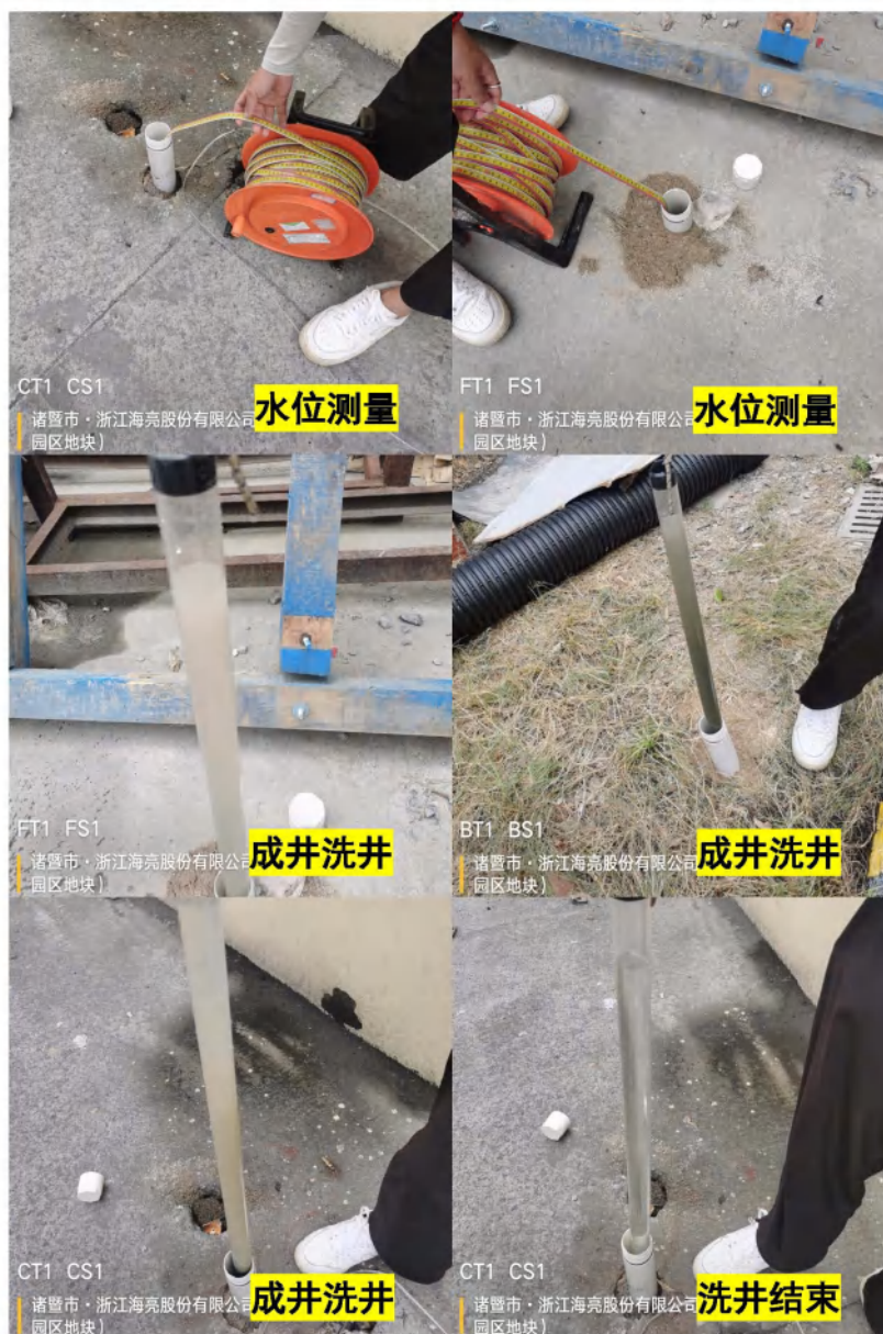
图 3-8 部分成井洗井照片
