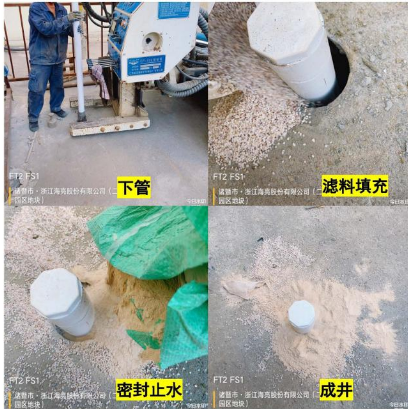
图 3-7 部分建井照片
