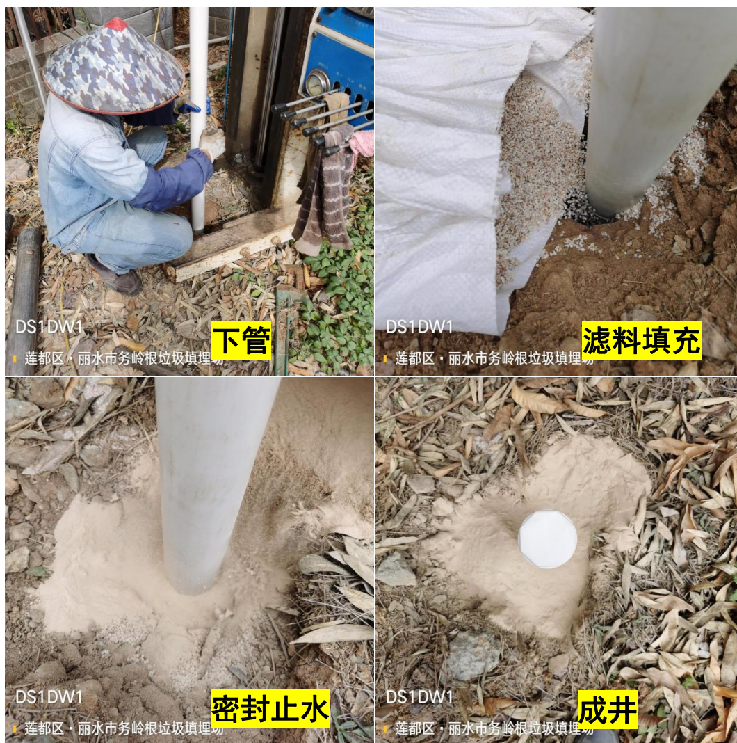
图 3-7 部分建井照片
