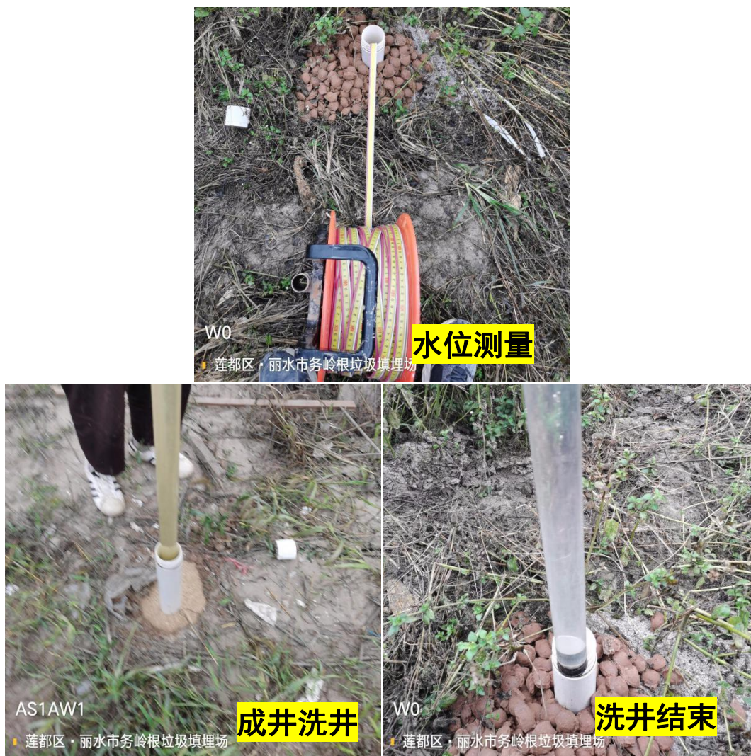
图 3-8 部分成井洗井照片
