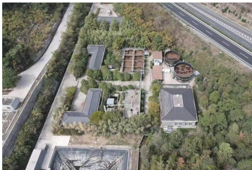
渗滤液处理站全景图 (池体均为地上式, 区域内 未见明显的跑冒滴漏现象)
