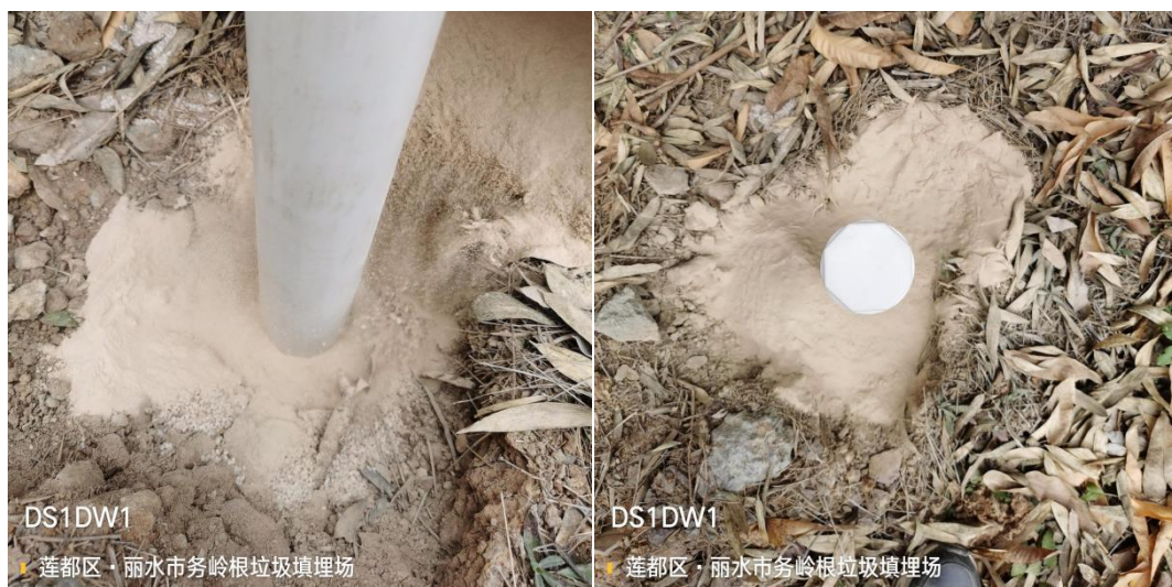
图 7.2-5 部分建井照片
