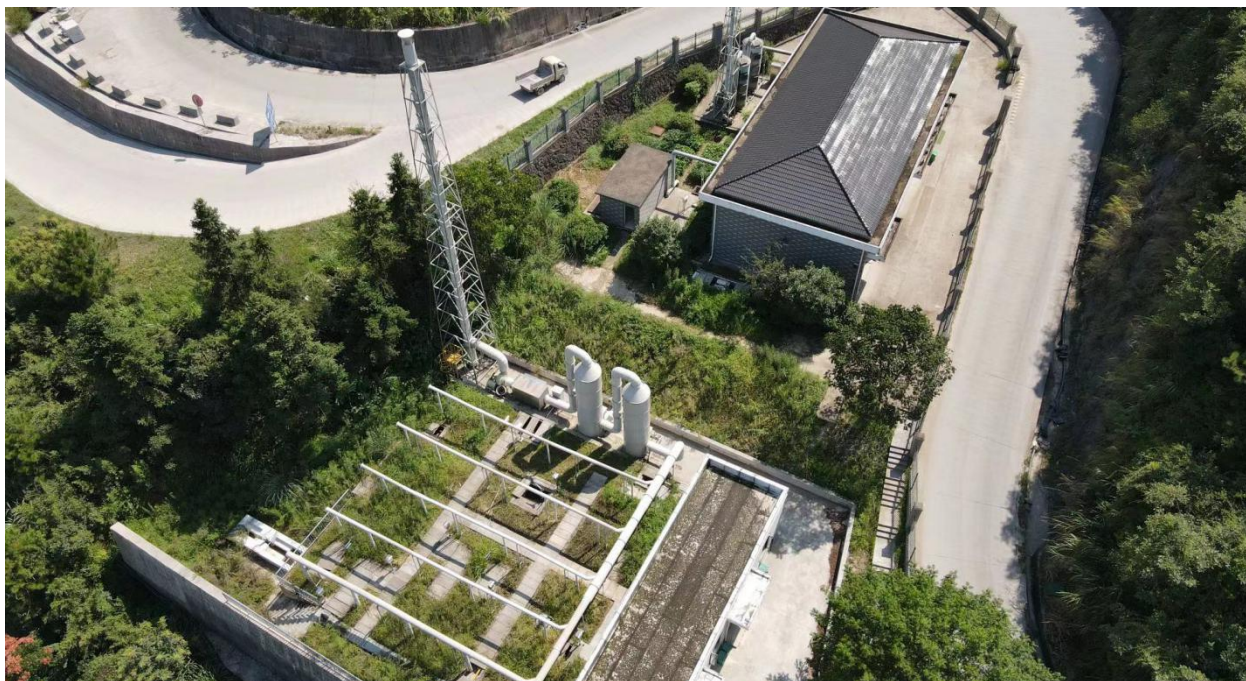
图 4.1.5-2 污水处理区臭气收集及处理
