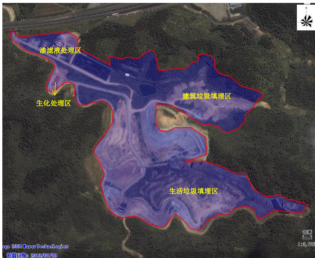
2013年07月（新建生化处理站，处理市区生活污水）
