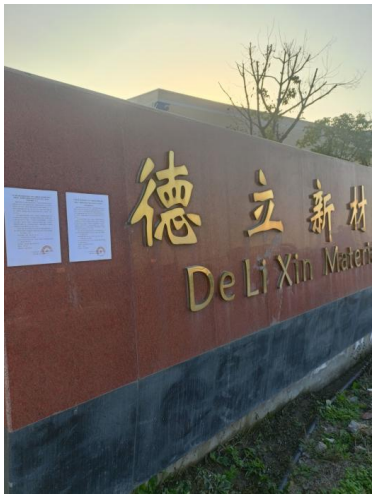
竣工、调试公示照片（远景）
