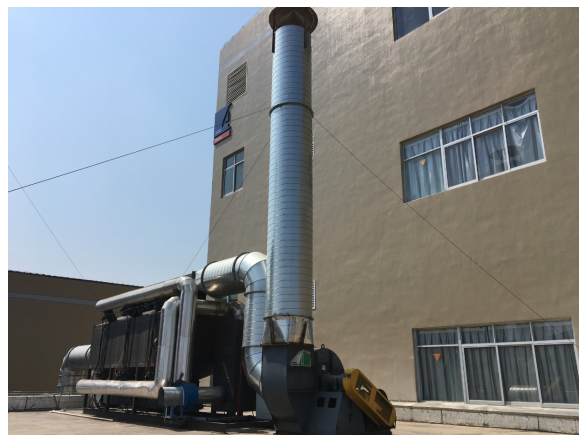
干式过滤器+活性炭吸附-脱附+催化燃烧装置
