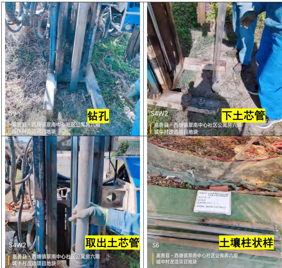
图 5.1-2 典型现场钻孔及取样成果照片
