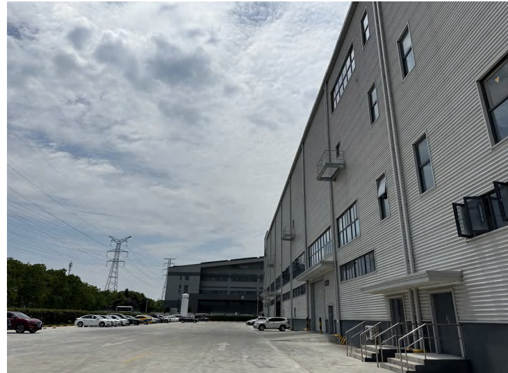
南侧 海易智能装备园区厂房
