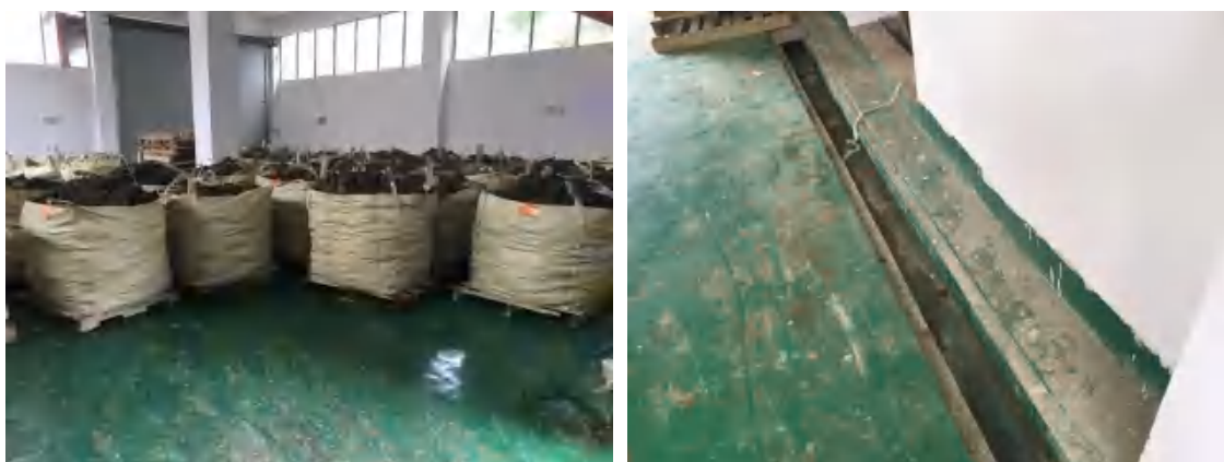
图 4.1-8 污泥（危废）仓库
