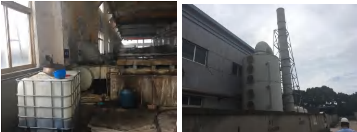
图 4.1-4 酸洗废气收集及处理
