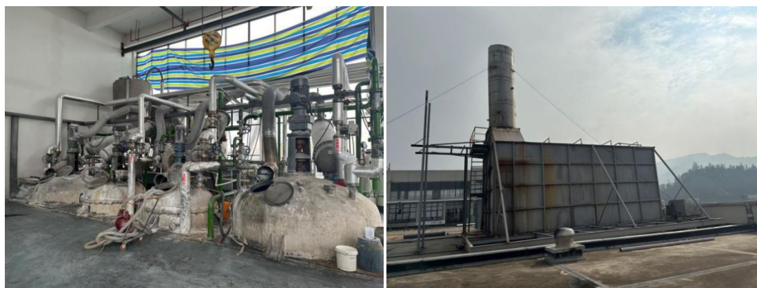
反应釜废气收集系统（最右侧反应釜为锦香源
